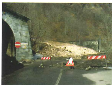
Fig. 7 - Interruzione della sede stradale della S.S. n. 25 del Moncenisio in loc. S. Martino, scesa il 24 marzo 1996. Sulla sinistra si nota un particolare dell'imbocco della galleria paravalanghe realizzata nell'800 per la ferrovia Fell, ora abbandonata.
